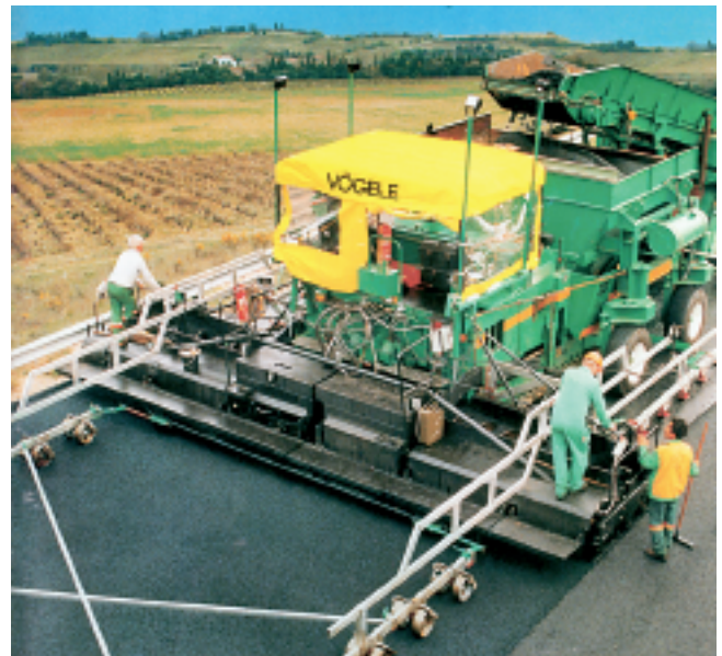
Рис. 5. Двойная французская лыжа при укладке асфальтобетонного покрытия укладчиком «Фегель 2500 Супер»
